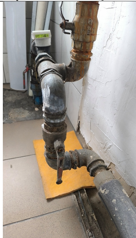
Węzeł wodomierzowy
